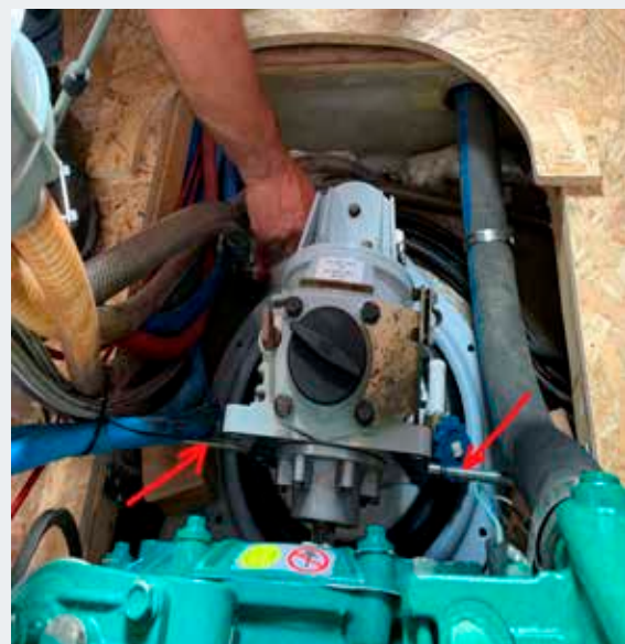
Houten blokken stutten de motor, de pennen steken in de saildrive en steunen op de houten blokken
